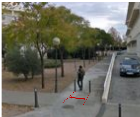
Figura 10 – Un espacio cuyo diseño original cumple los criterios de accesibilidad, se hace inaccesible (no cumple los estándares mínimos de anchura libre) por el necesario empleo de bolardos para impedir la circulación de los vehículos privados.
